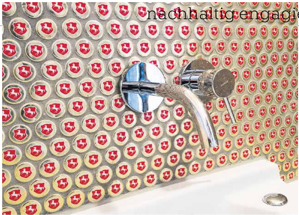
Alte Kronkorken statt neue Fliesen: Das Recyclinghaus in Hannover sieht gut aus und hat eine noch bessere CO 2 -Bilanz Foto: Julian Stratenschulte/dpa/picture alliance
